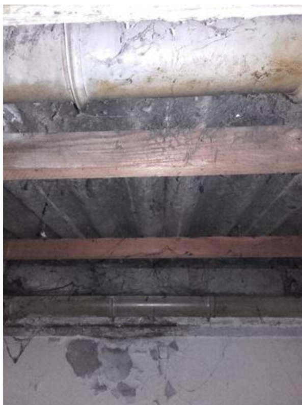
Réserve (Rdc) - Toiture - Couverture
