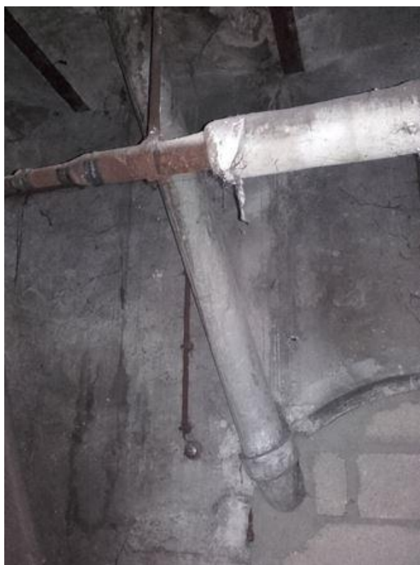
Cave (Sous-sol) - Conduit - Fibre ciment
